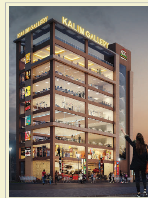
KALIM GALLERY EM Bypass
